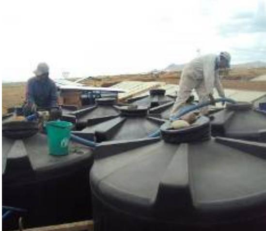
**Fotografía N° 2 y 3:** Tanques de almacenamiento de 5.000 litros, para el proceso de tratamiento de la orina durante un periodo de 3 meses para estabilizar los micronutrientes y fertilizantes.
