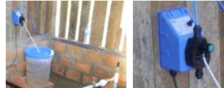
El generador para el bombeo y dosificador de cloro están instalados en una caseta para su protección.
