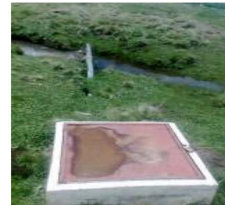
**Conducción de agua cruda.-**El agua es conducida por tuberías de PVC de un diámetro de 2”, por gravedad hasta el reservorio.
