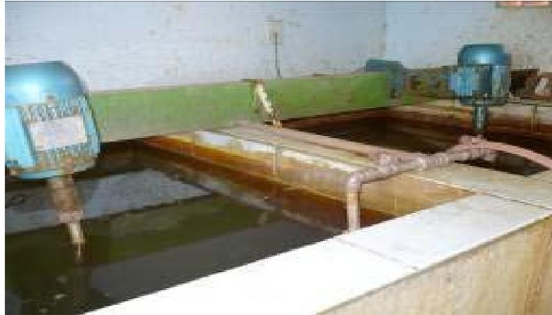
El sulfato es inyectado al ingreso del agua al sistema de tratamiento mediante una bomba peristáltica continua.
