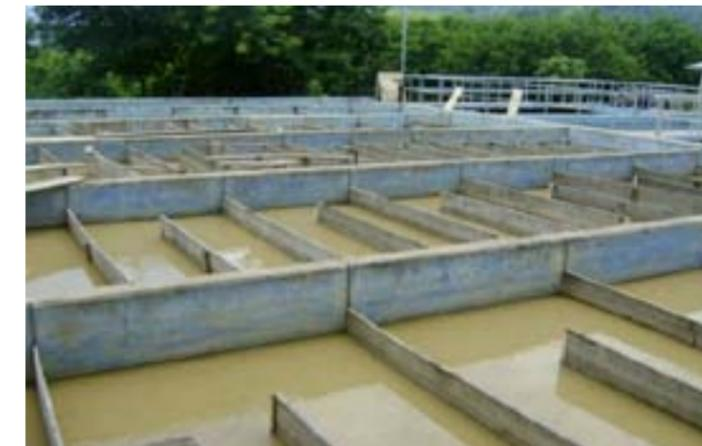
**Sedimentación:** Se realiza mediante cuatro sedimentadores de placas o lamelas. Se evidencia formación de algas debiéndose realizar el mantenimiento con mayor frecuencia.
