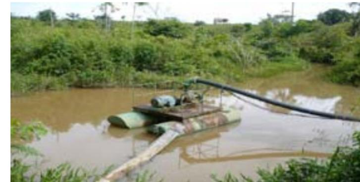
**Conducción de agua cruda:** El agua bombeada de la captación es transportada a través de una línea de impulsión, hasta la planta de tratamiento, resaltando que la tubería es muy antigua.
