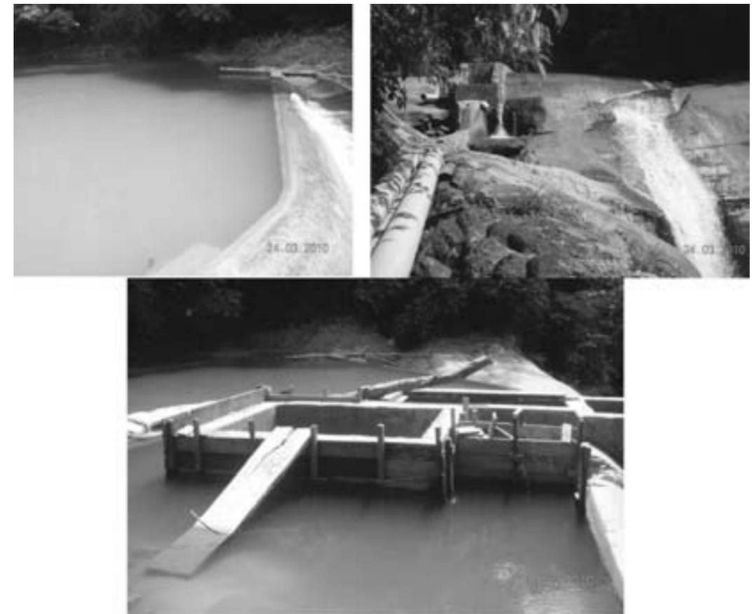
La derivación se realiza con una obra de toma de vertedero lateral construida con H<sup>2</sup>C° y provista de una tubería perforada para evitar el ingreso de material flotante. La obra de toma se está cambiando (abril/2010) por un sistema similar y de igual capacidad, la cual se espera pueda mejorar la eficiencia de captación. Se capta un valor medio de 45 l/s durante todo el año, la calidad del agua es buena en general y su turbidez no aumenta de forma significativa.
