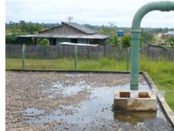
El tratamiento principal es la coagulación, aplicando para ello sulfato de aluminio 40 kg al día, dependiendo de la turbidez del agua bruta; cuya mezcla se realiza en el canal de conducción de la planta. La desinfección del agua se realiza con solución de Dicloro, cuya cantidad diaria es de 6 kg, el cual es introducido a la salida de la planta de tratamiento.
