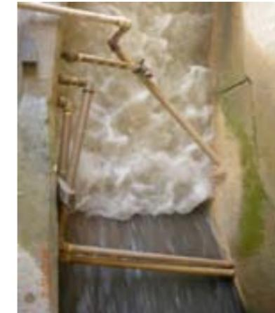
**Coagulación:** Aplicación de sulfato de aluminio para la coagulación básica y olielectrolito catiónico para mejorar el rendimiento, la mezcla se realiza directamente en el canal de conducción de la planta.
